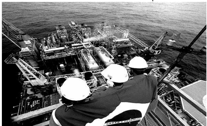
Técnicos em Plataforma de perfuração de poços de petróleo em águas profundas (tecnologia nacional desenvolvida pela COPPE/UFRJ, em parceria com a PETROBRAS).
